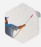
Enduit de façade
