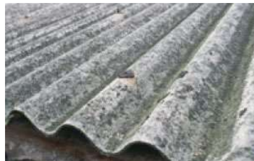
Plaques de toiture en amiante-ciment
